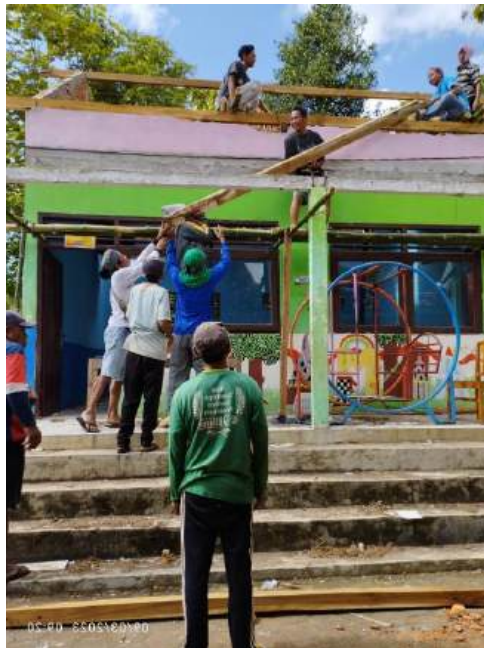
Rehabilitasi Gedung Paud di Macanmati
